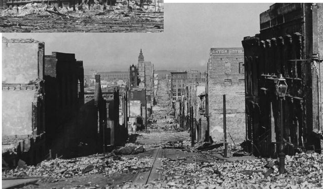
San Francisco 1906. Imágenes del terremoto de 7,8 en la escala de Richter. Biblioteca del Congreso de EEUU.
