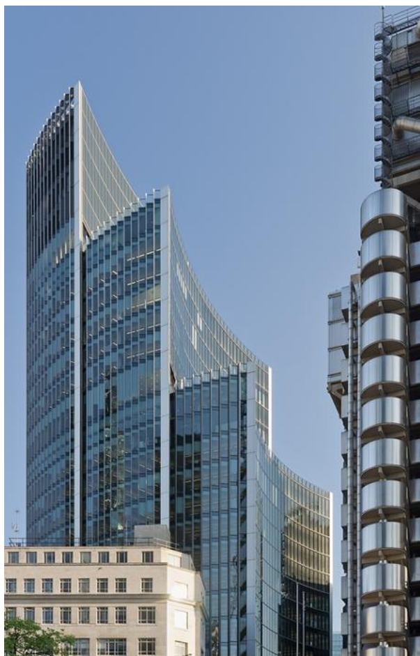
Edificio 51 Lime o Willis building
