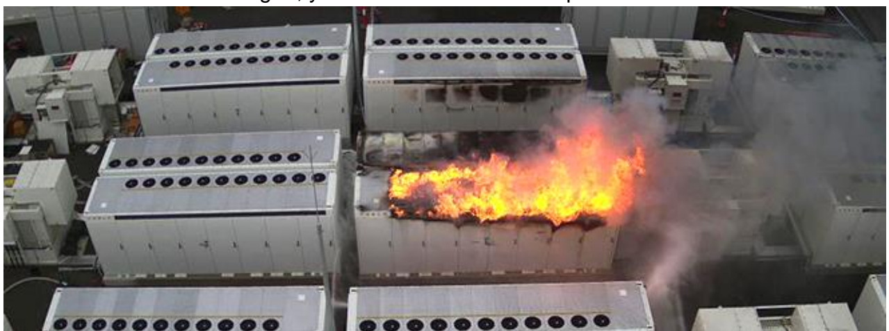
Incendio de un sistema público de acumulación de energía.
