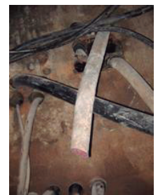
DAÑOS DE CONTRATISTA SOBRE CABLES TELEFÓNICOS PERTENECIENTES A CABLEADO EN OPERACIÓN DEL COMITENTE
